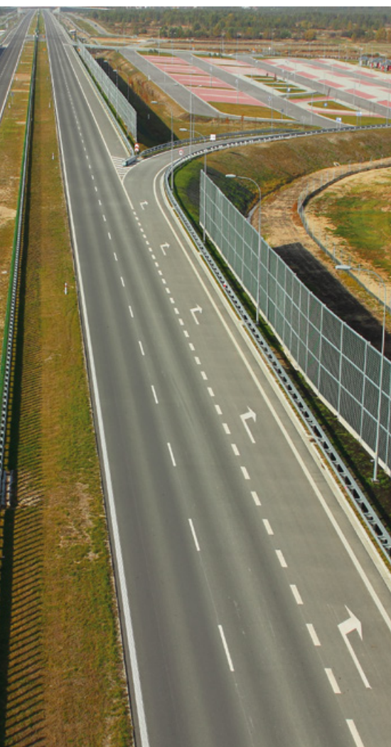
Autostrada A4 Dębica-Rzeszów
