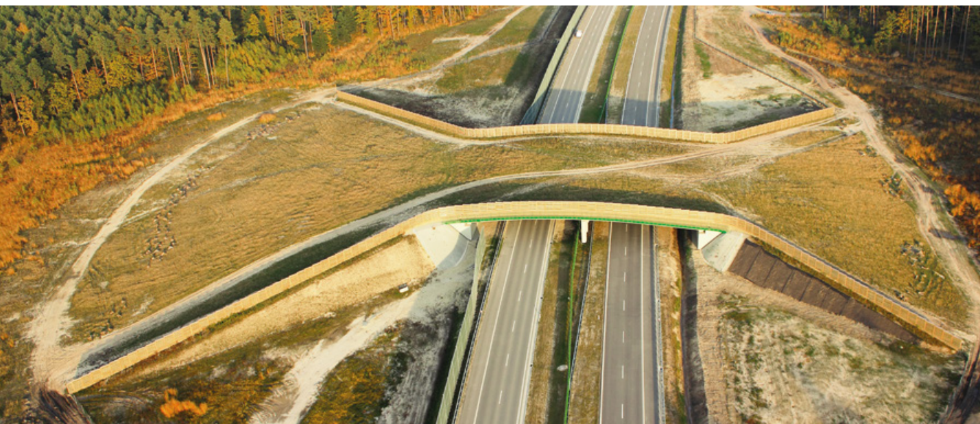
Autostrada A4 Dębica-Rzeszów
