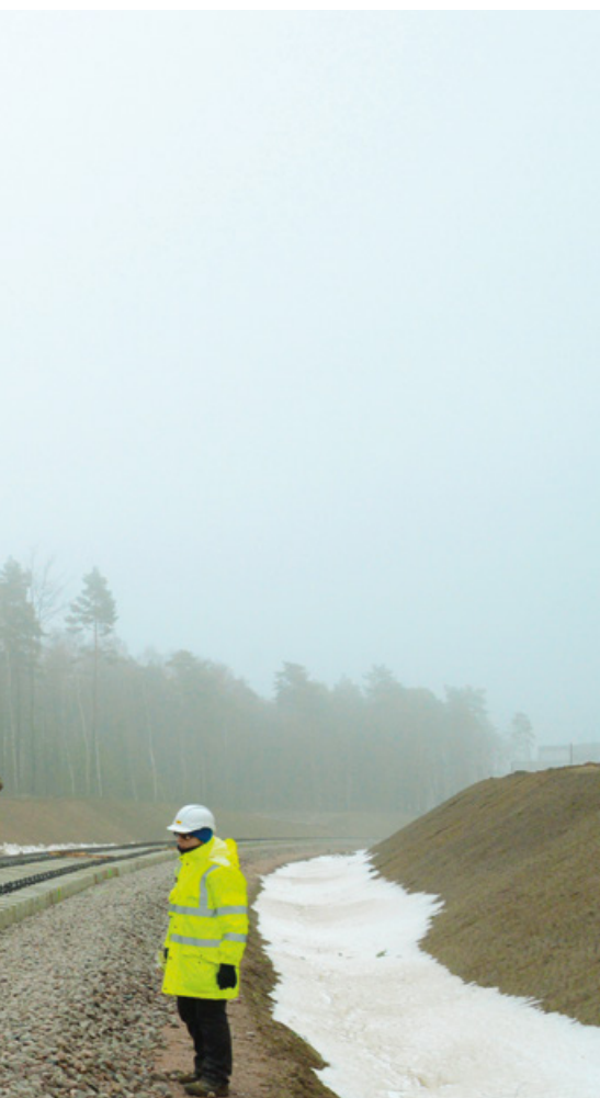
Budowa Pomorskiej Kolei Metropolitalnej w Gdańsku
