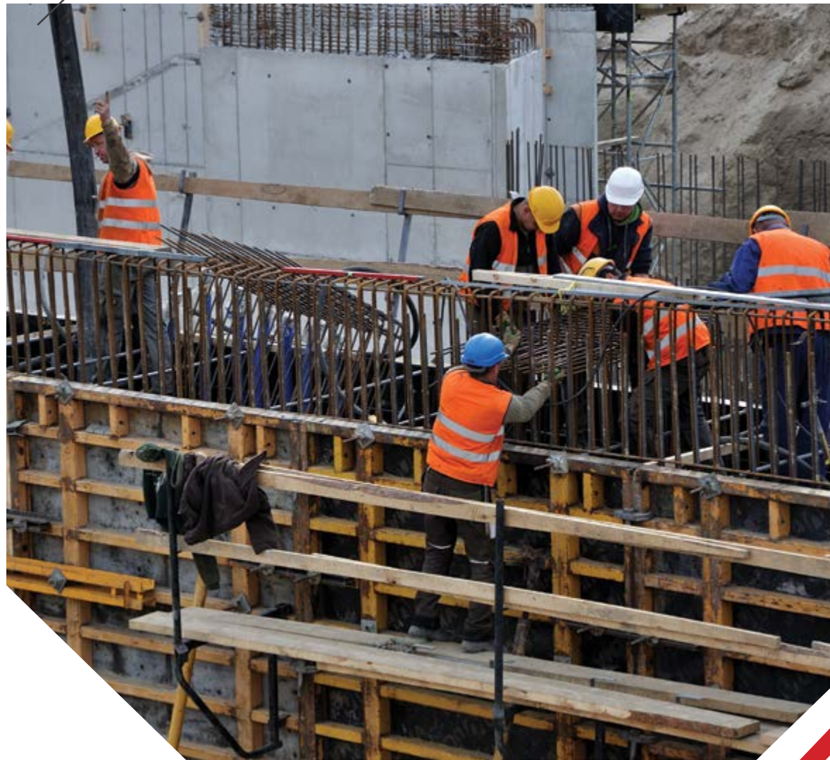
fot. Budowa Pomorskiej Kolei Metropolitalnej
